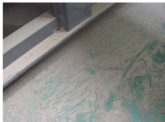
建物の床にたまったほこり
